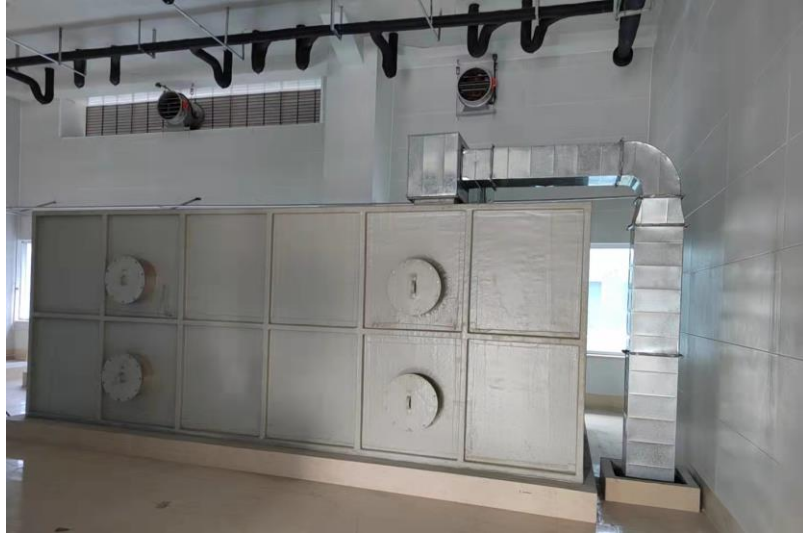
图 3.1-17 污水处理站废气治理设施图
